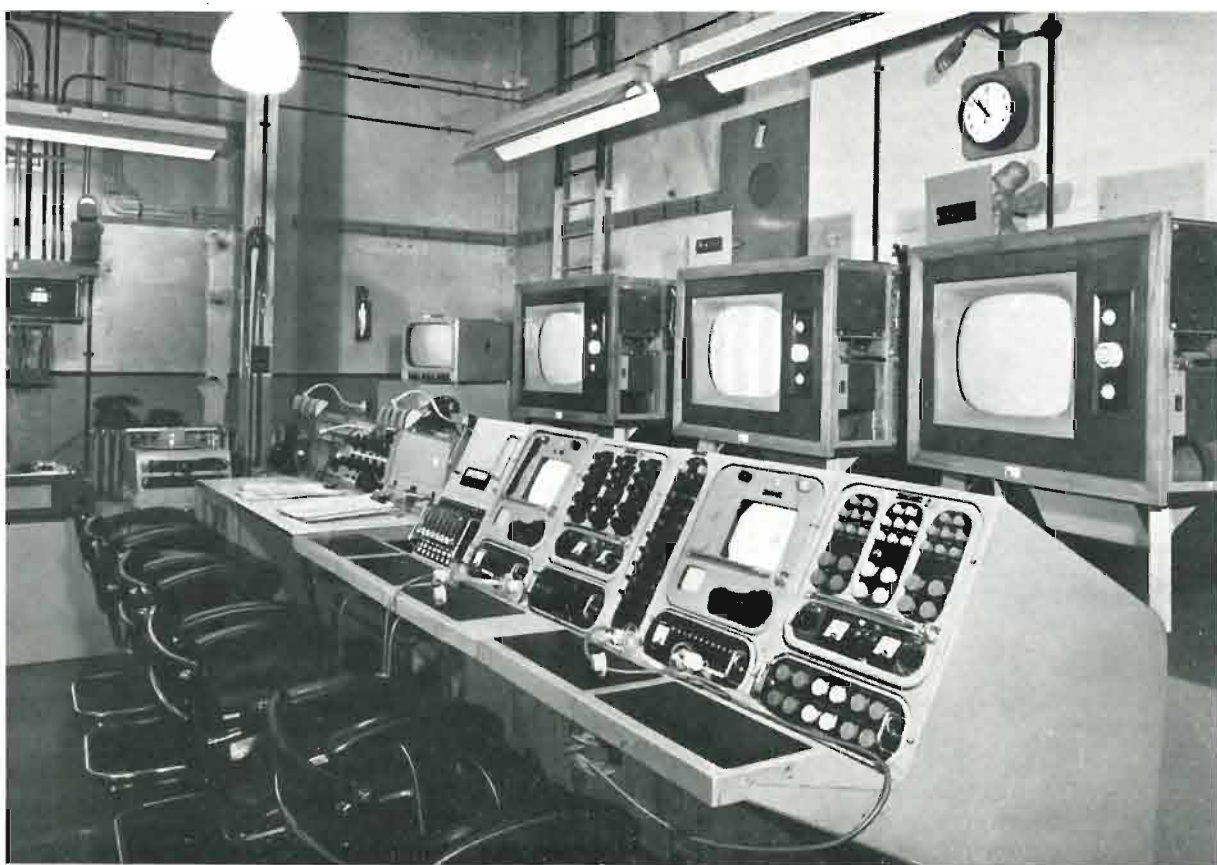
Fig. 4 - I banchi di controllo del trasmettitore sperimentale a colori della BBC. Nell'ordine, da sinistra a destra: le apparecchiature audio, la sezione mescolazione e dosaggio; il comando dei monitori.
